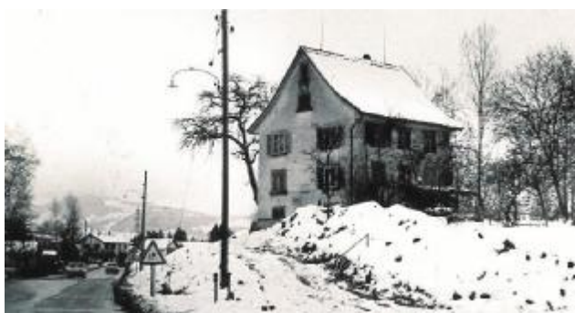
Das Haus von „Buume Höch“ (Robert Baumann), vermutlich kurz vor dem Abbruch.
