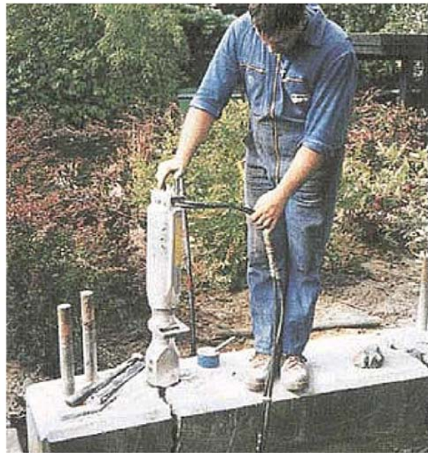
Abbruch einer Mauer (alle Bilder aus dem Internet)
